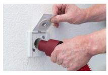
Stecken Sie den Schlauch in die Saugsteckdose.
