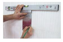
1. Richten Sie die Wandhalterung in der für Sie optimalen Höhe (ca. 1.60 m) an der Wand aus und kennzeichnen Sie die Bohrungen an der Wand.
