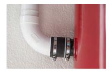
Der Saugstutzen befindet sich links unten am Zentral-Staubsauger. Schieben Sie die Gummimanschette und die anderen beiden Schlauchschellen über den Stutzen. Ziehen Sie nun die Manschette auch über die Saugleitung. Sichern Sie die Manschette mit den Schlauchschellen einmal über dem Stutzen und einmal über der Saugleitung.
