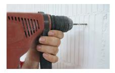
2. Bohren Sie die fünf Löcher mit einem 6 mm Steinbohrer so tief, dass die mitgelieferten Dübel restlos in der Wand versenkt werden können.
