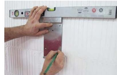
1. Richten Sie die Wandhalterung in der für Sie optimalen Höhe (ca. 1.60 m) an der Wand aus und kennzeichnen Sie die Bohrungen an der Wand.
