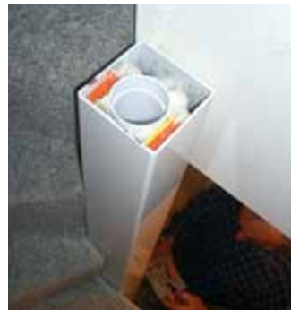
invisible dans le poteau d'escalier
