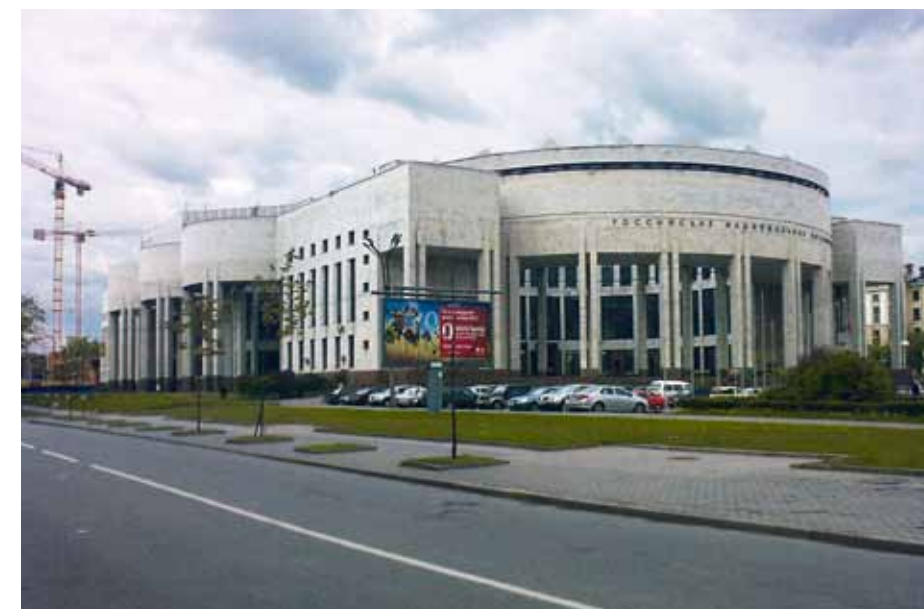
Bibliothèque nationale russe, St. Petersburg (2 x 20 kilowatt centrale d'aspiration ProfiVac avec 487 prises d'aspiration)
