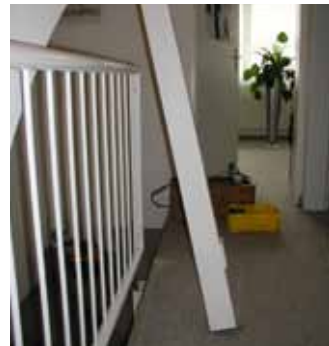
enlever le poteau en bois
