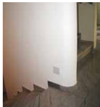
visible dans la cage d'escalier
