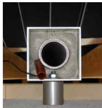
invisible dans le poteau d'escalier
